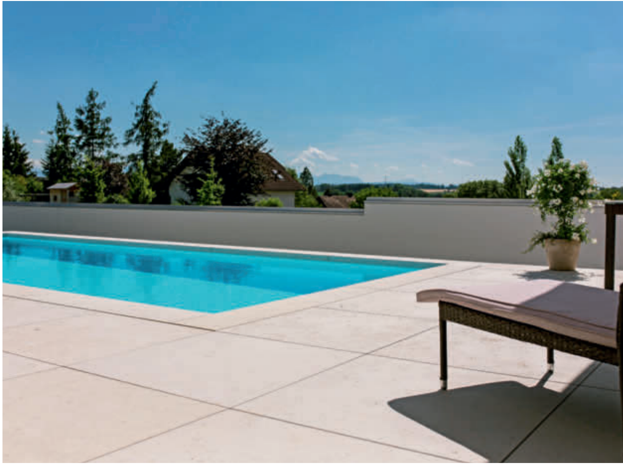
Wohnzimmerverlängerung: im zweifachen Gefälle gefräste Platten aus sandgestrahltem Dietfurter Gala.
