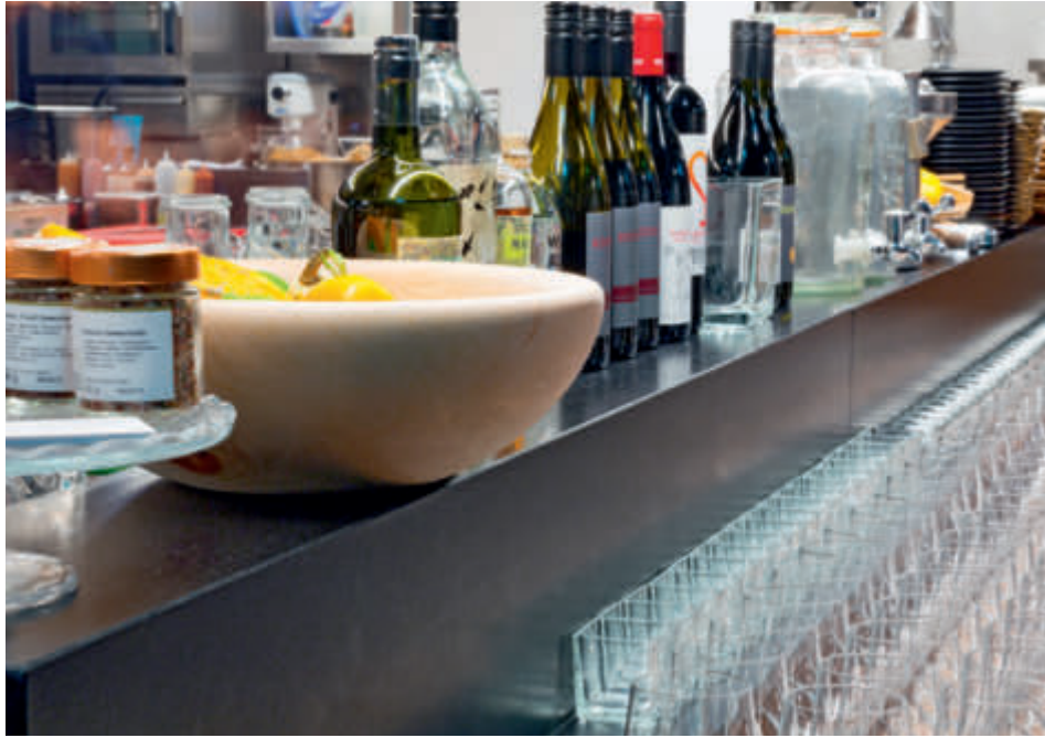
Wie aus einem Block: Die Thekenplatten sind auf Gehrung verklebt.
