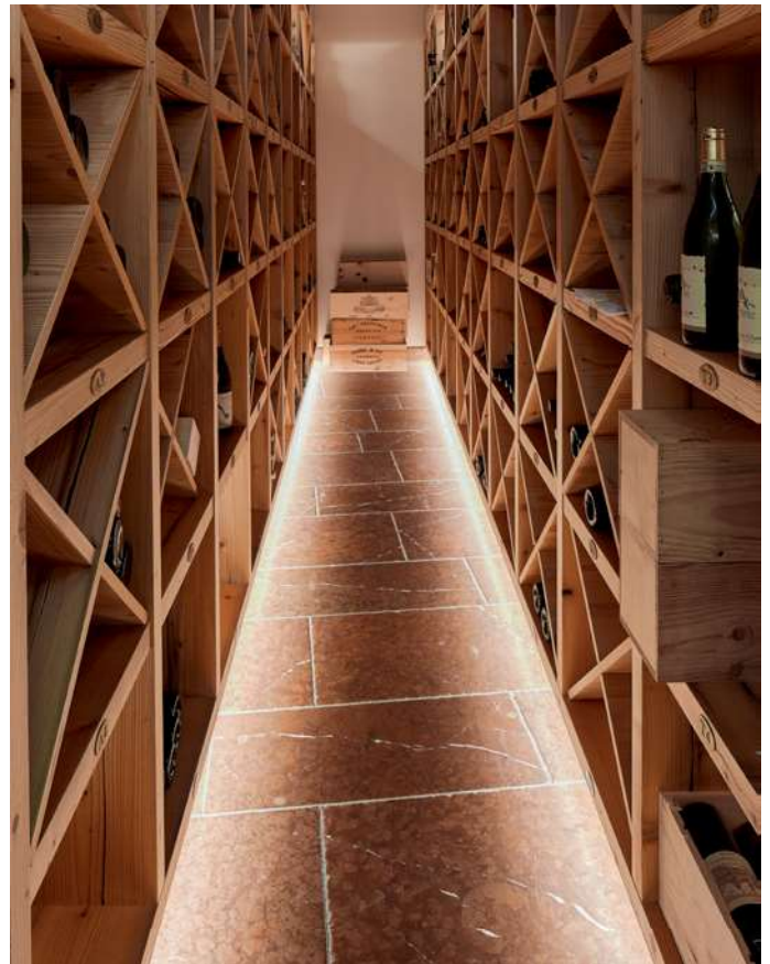
Blick in den Weinkeller: Das Streiflicht hebt die gebrochenen Fugenkanten hervor.
