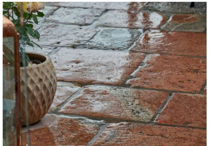
Blick in den Weinkeller: Das Streiflicht hebt die gebrochenen Fugenkanten hervor.
