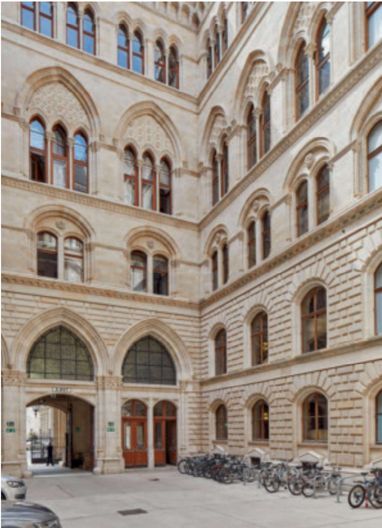
Die Sanierung der Höfe 3 und 4 wurde bereits 2016 vollendet.
